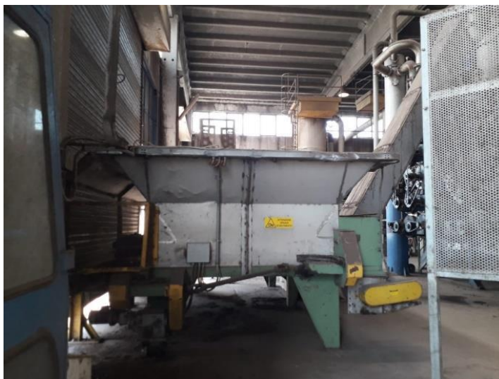
Figura 4: Tramoggia contenente la vinaccia prima dell'ingresso nell'impianto di disalcolazione
