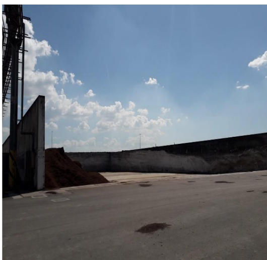
Figura 1: vasca di stoccaggio vinacce in cemento armato
